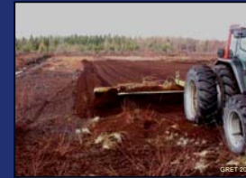
1- Préparation du terrain
