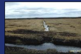
6- Blocage des canaux de drainage pour remouiller le site
