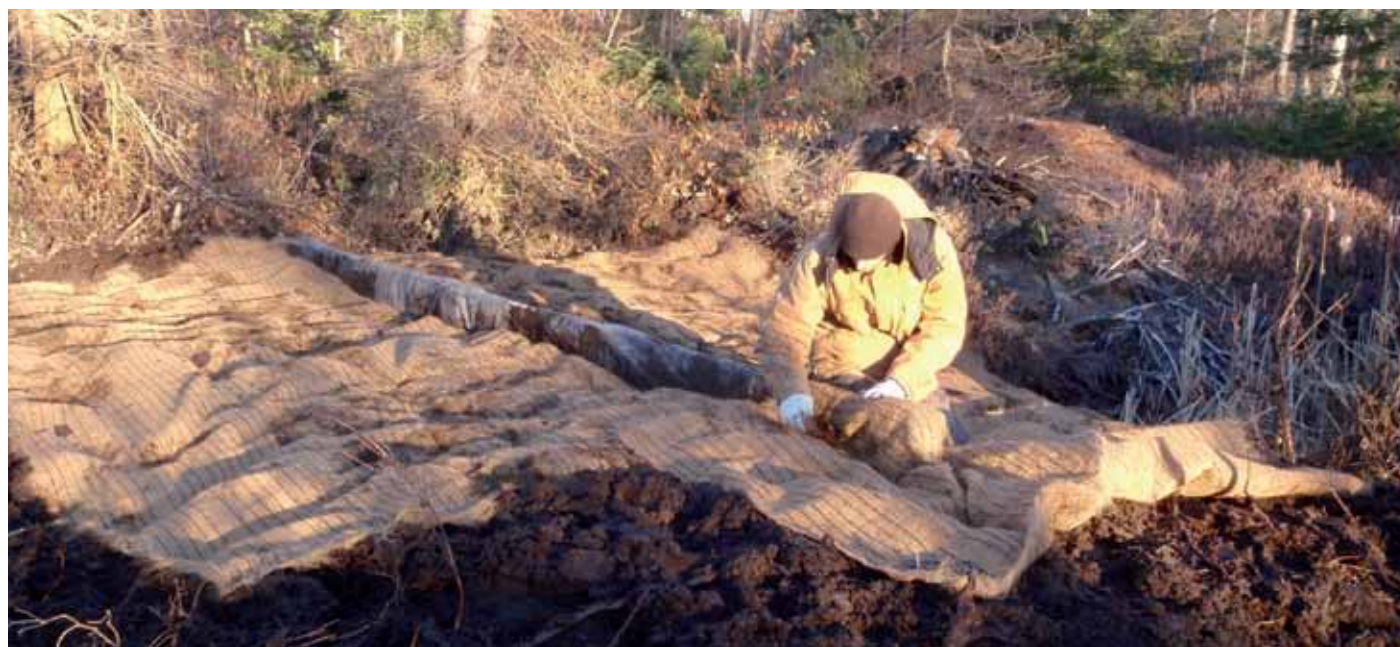
Figure 21. Installation d'un filet de stabilisation à la tourbière de la Grande plée Bleue (Québec).
