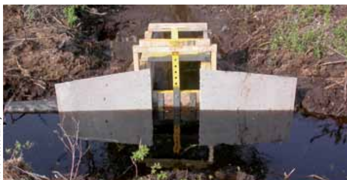
Figure 33. Caisson de régulation avec contrôle par le haut (1 re photo), installé à l'embouchure d'un bassin à Sainte-Marguerite, au Québec. Caisson de régulation avec contrôle par le bas (2 e photo), installé à l'embouchure d'un bassin à Shippagan (Nouveau-Brunswick).
