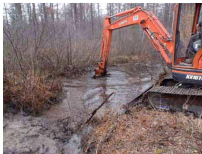
Figure 34. Formation d'une mare permettant le prélèvement de matériel de tourbe pour la construction d'un barrage de tourbe à la tourbière de la Grande plée Bleue (Québec).
