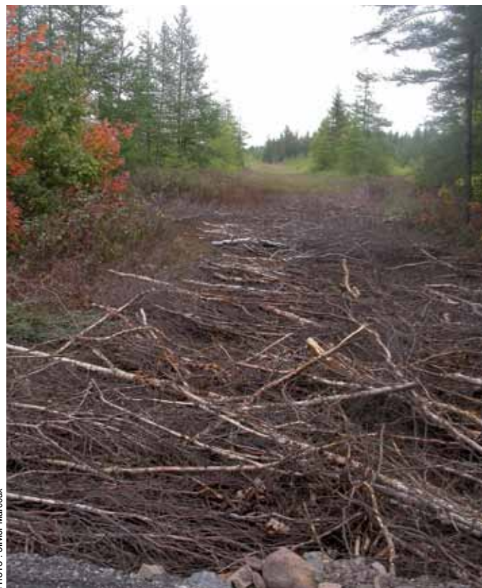
Figure 17. Chemin en rondins de bois et en branches pour le passage de la machinerie à la tourbière de la Grande plée Bleue (Québec).
