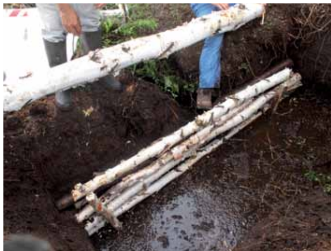
Figure 25. Barrage en rondins de bois – approche déconseillée.
