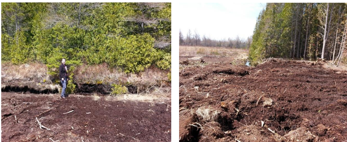
Figure 22 : Marge de la tourbière de Bic–Saint-Fabien avant (gauche) et après (droite) les travaux de remodelage, en vue de rétablir la connectivité hydrologique entre le secteur restauré et celui naturel adjacent.
