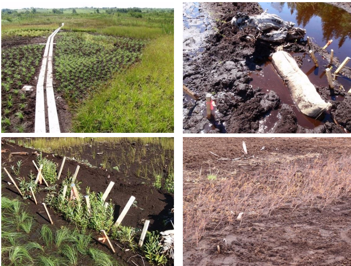
Figure 16 : Méthodes de contrôle de l'érosion utilisées à Bic-Saint-Fabien. En haut, à gauche : plantations d'herbacées. En haut, à droite : boudins de bois raméal fragmenté. En bas, à gauche : fagots d'arbustes. En bas, à droite : boutures d'arbustes.
