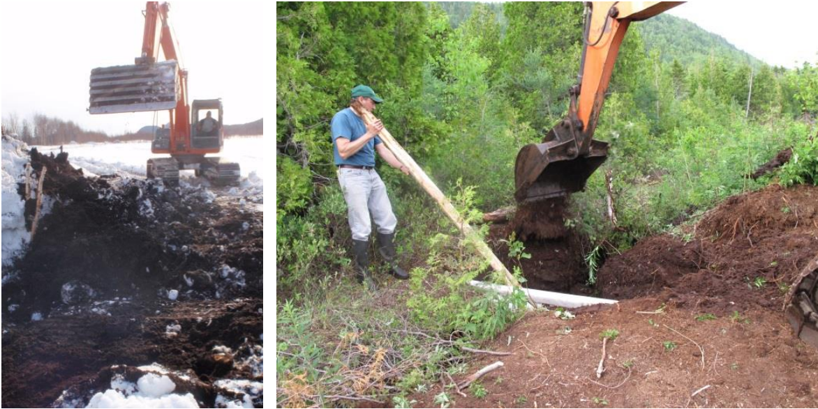
Figure 15 : Rétablissement de l'hydrologie à la tourbière de Bic-Saint-Fabien. À gauche : blocage initial des canaux de drainage en mars 2010. À droite : construction de barrages afin de bloquer l'eau des canaux de drainage en juillet 2010.
