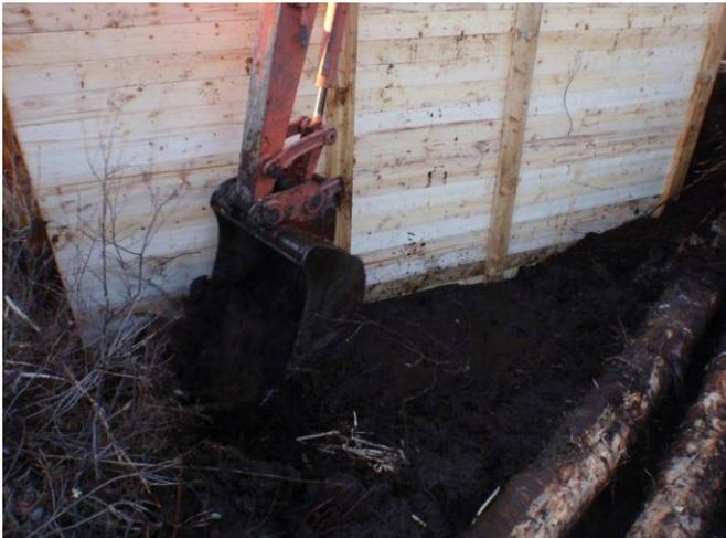
**Enfouissement et stabilisation de la base de la palissade du barrage 4 avec de la tourbe.**
