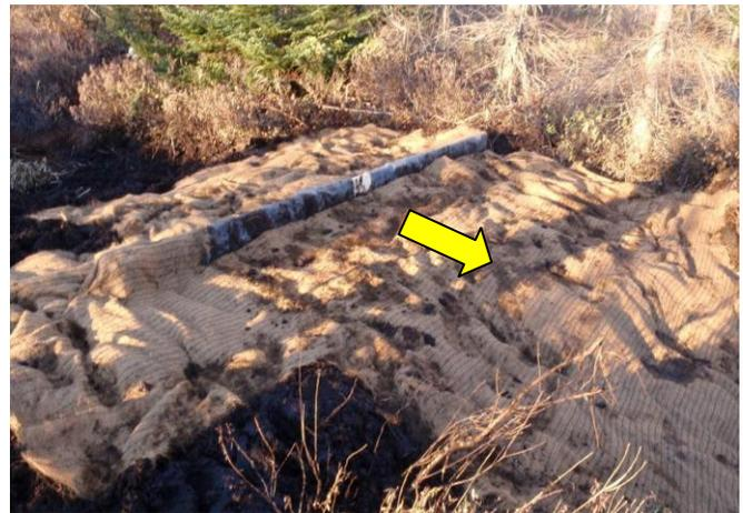
**Pose de nattes de coco afin de stabiliser la tourbe contre l'érosion (barrage 4).**
