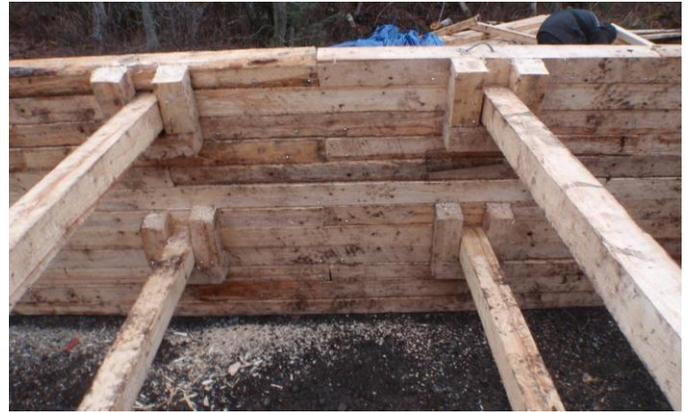
**Structures en U pour stabiliser les travers de 4x4 lors de leur installation entre les deux palissades (barrage 6).**
