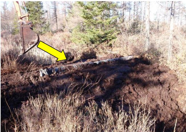
**Formation de pentes douces en amont et en aval de la palissade (barrage 4).**
