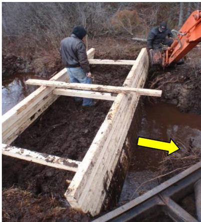
**Installation de la section supérieure du barrage double avec comblement (barrage 6).**
