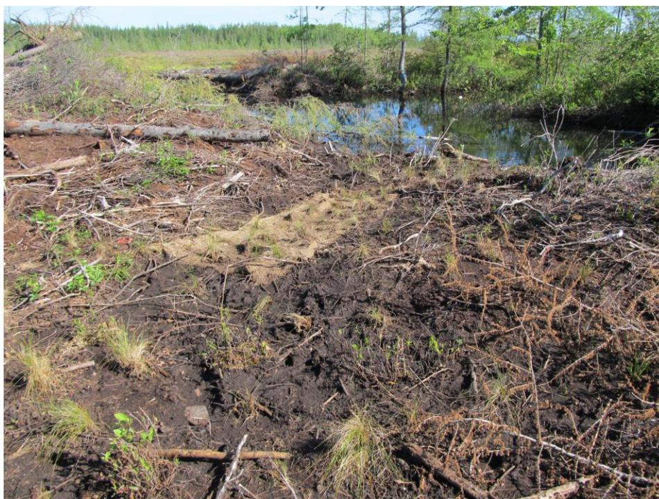
**Figure 10 : Fibre géotextile de fibre de coco pour contrer l'érosion aux abords du barrage G3.**
