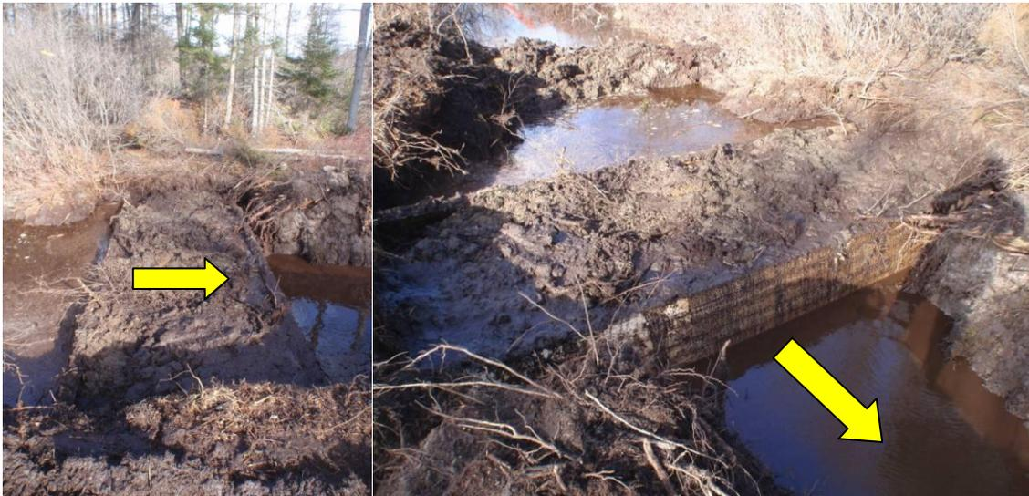
**Section inférieure constituant la base du barrage double avec comblement (barrage 6) prête à recevoir la section supérieure.**
