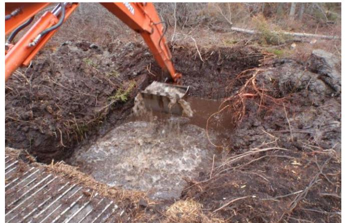
**Excavation de la tranchée jusqu'à l'horizon minéral et construction de deux barrages temporaires en aval et en amont du barrage 6.**
