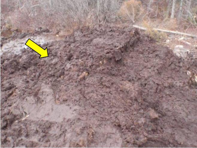
**La palissade double (barrage 6) est enfouie dans la tourbe avec deux pentes douces en aval et en amont du barrage.**
