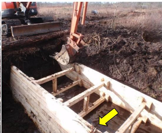
**Installation et mise à niveau de la base de la palissade double à l'aide de la pelle mécanique et enfoncement de cette palissade double dans l'horizon minéral pour la construction du barrage 6.**
