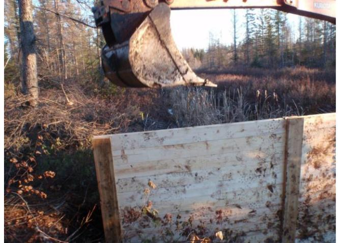
**La pelle mécanique enfonce la palissade du barrage 4 dans la tourbe et l'horizon minéral.**
