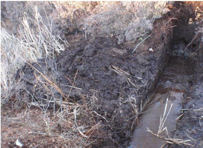
Excavation de la tranchée et formation de barrages temporaires (barrage 4).
