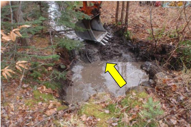
Barrage temporaire en aval du ponceau avec le matériel provenant du fond du canal à la sortie du ponceau (barrage 3).
