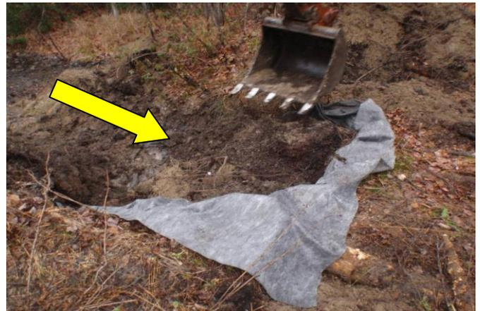
Formation d'une poche de géotextile au fond du canal en amont du ponceau et construction du barrage de tourbe grâce au matériel provenant du barrage temporaire et d'une zone d'emprunt (barrage 3).
