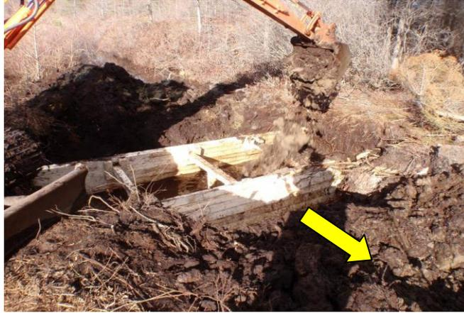
**Comblement de l'espace entre les deux palissades de la base du barrage double (barrage 6) avec de la tourbe.**
