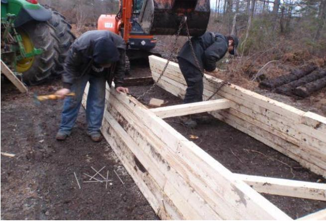
**Construction de la section supérieure du barrage double (barrage 6).**
