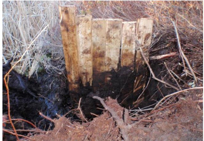
**Essai de la technique d'enfoncement vertical de madriers au barrage 5; constatation des ouvertures entre les madriers.**
