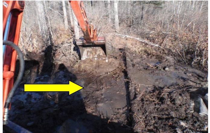
**Positionnement de la palissade et comblement des poches de géotextile avec de la tourbe bien tassée (barrage 1)<sup>2</sup>.**
