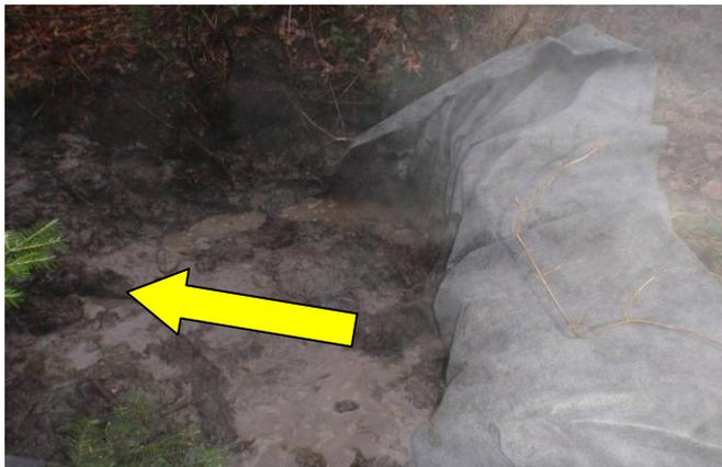
Formation d'une poche de géotextile au fond du canal en aval du ponceau (barrage 3).
