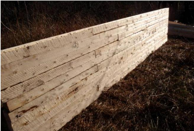
**Barrage 1 : Construction d'une palissade horizontale avec madriers de 12 pieds (4 pouces x 4 pouces).**
