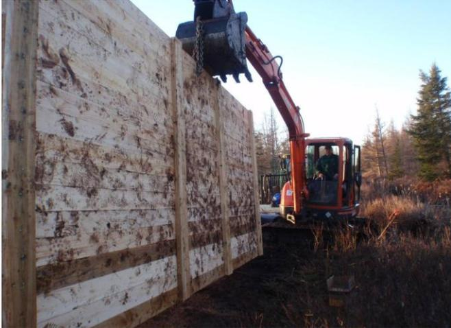
**Transport de la palissade du barrage 4 à l'aide de chaînes.**
