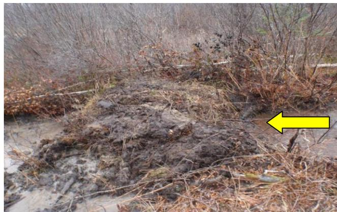
Le barrage de tourbe est végétalisé et surélevé afin de contrer l'effet d'affaissement du matériel fraîchement déplacé (barrage 2).
