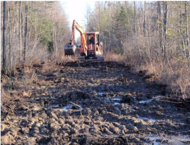
Comblement du canal Beauharnois entre les barrages 1 et 4 (voir Figure 3 du rapport) avec le matériel provenant du chemin longeant ce canal de drainage.
