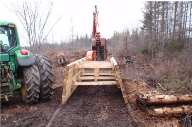
**Transport de la palissade double (section inférieure), à l'aide de chaînes, jusqu'au site du barrage 6.**
