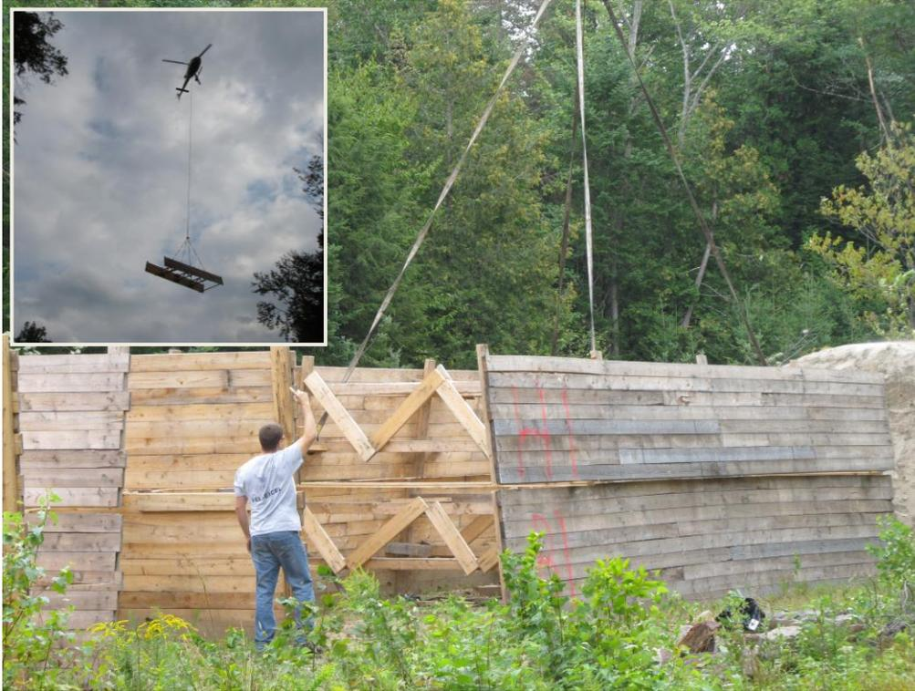
**Figure 6 : Transport des palissades par hélicoptère.**
