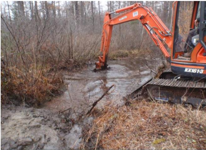
Récolte de matériel (mélange de tourbe, sable et argile) au fond de la mare et formation du barrage (barrage 2).
