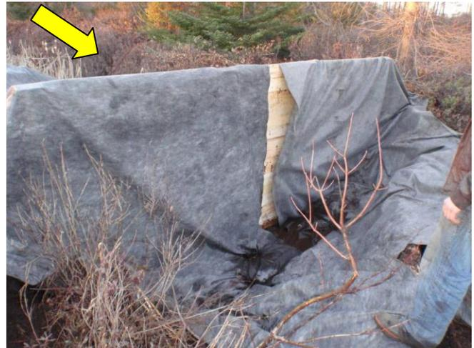
**Formation des poches de géotextile aux extrémités de la palissade du barrage 4.**
