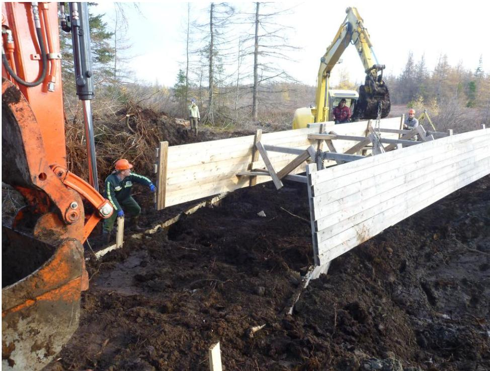
**Figure 7 : Installation d'une palissade à l'aide d'excavatrices.**
