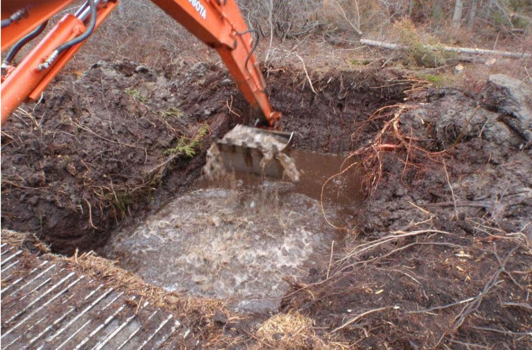
**Figure 30. Excavation de la tranchée jusqu'à l'horizon minéral et construction de deux barrages temporaires en aval et en amont du barrage 6.**
