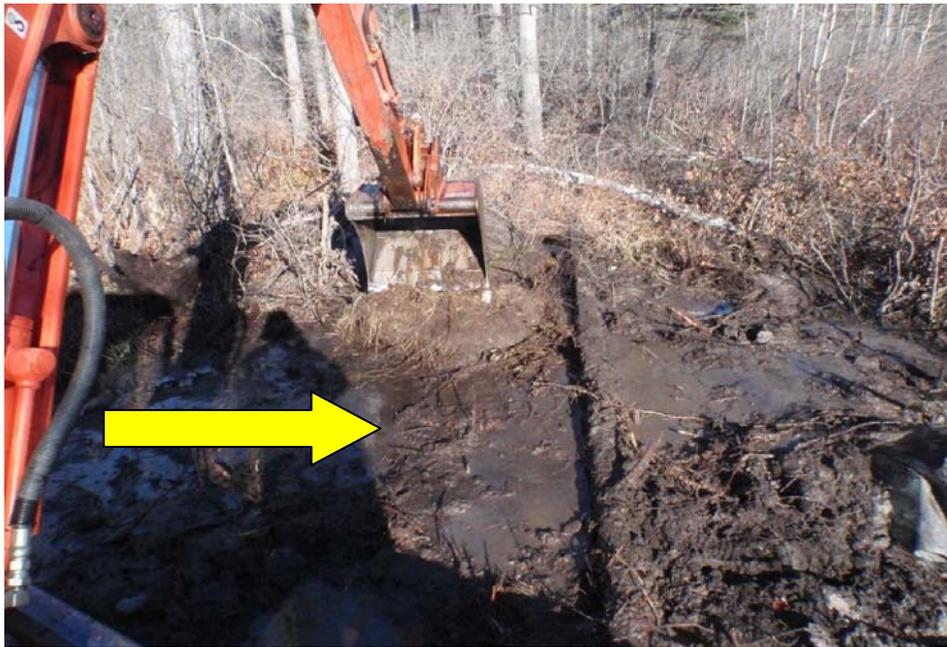
**Figure 6. Positionnement de la palissade et comblement des poches de géotextile avec de la tourbe bien tassée (barrage 1).**
