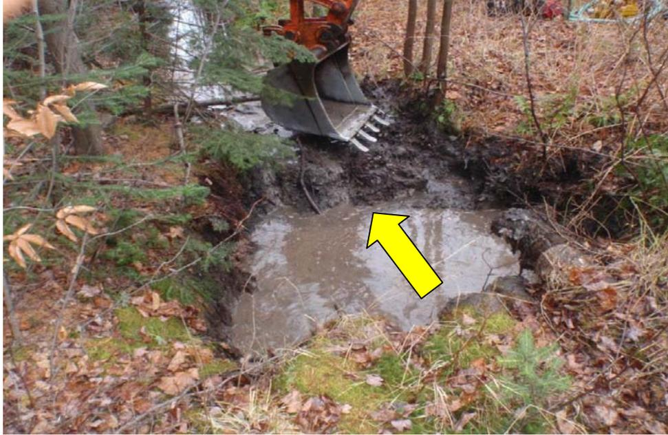
**Figure 11. Barrage temporaire en aval du ponceau avec le matériel provenant du fond du canal à la sortie du ponceau (barrage 3).**
