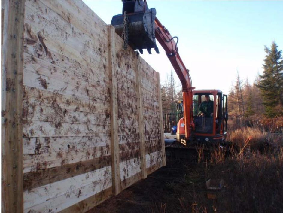
**Figure 17. Transport de la palissade du barrage 4 à l'aide de chaînes.**
