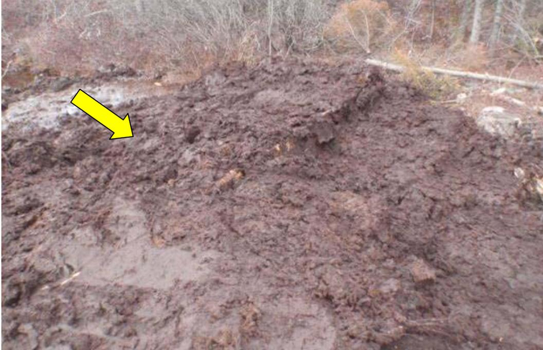
**Figure 36. La palissade double (barrage 6) est enfouie dans la tourbe avec deux pentes douces en aval et en amont du barrage.**
