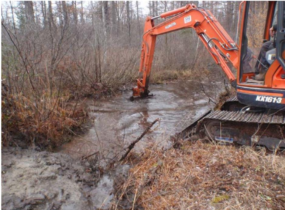
**Figure 8. Récolte de matériel (mélange de tourbe, sable et argile) au fond de la mare et formation du barrage (pour le barrage 2).**
