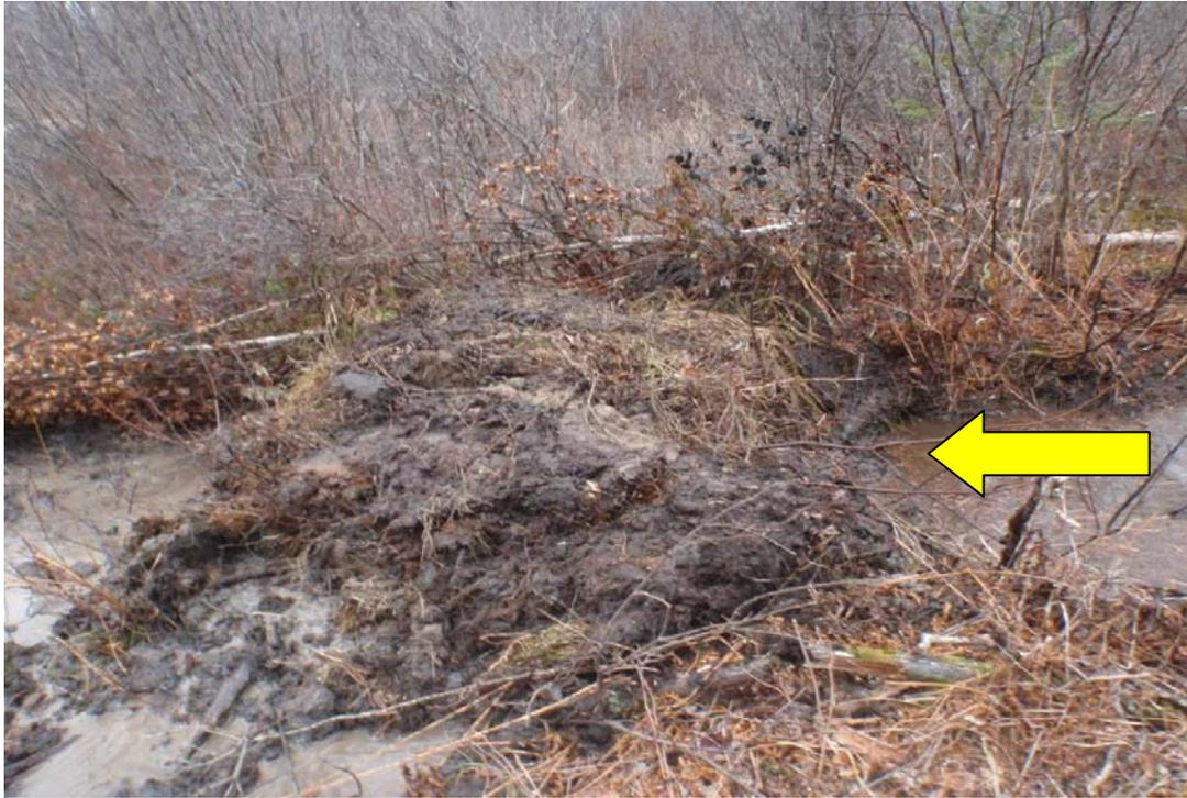
**Figure 10. Le barrage en tourbe est végétalisé et élevé afin de contrer l'effet d'affaissement du matériel fraîchement déplacé (barrage 2).**
