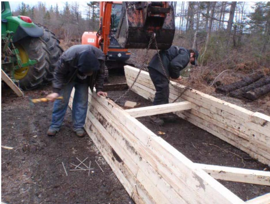
Figure 27. Construction de la section supérieure du barrage double (barrage 6).
