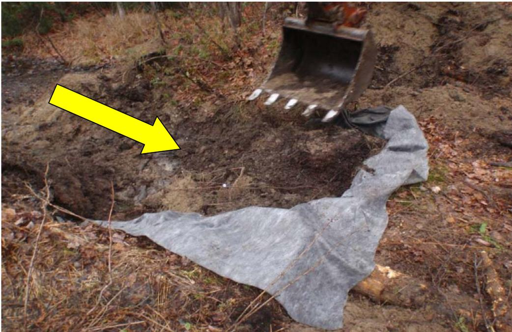
**Figure 12. Formation d'une poche de géotextile au fond du canal en amont du ponceau et construction du barrage de tourbe grâce au matériel provenant du barrage temporaire et d'une zone d'emprunt (barrage 3).**
