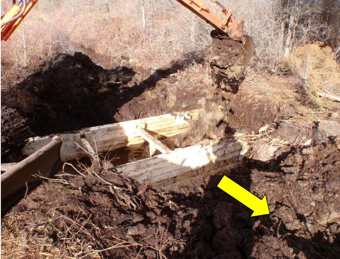
**Figure 32. Comblement de l'espace entre les deux palissades de la base du barrage double (barrage 6) avec de la tourbe.**
