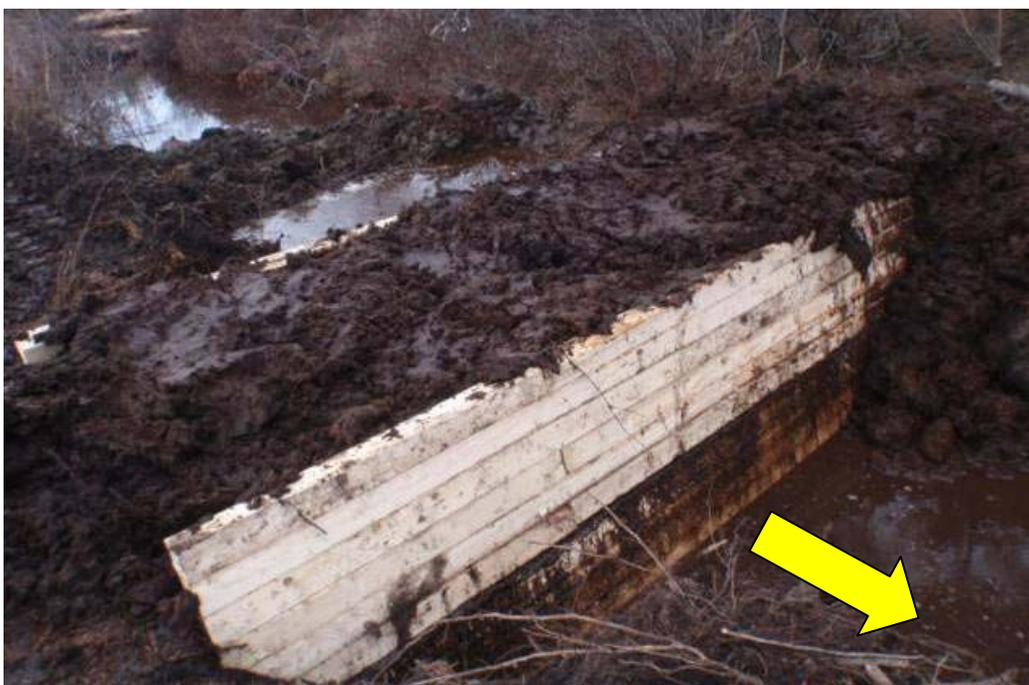
**Figure 35. La section supérieure comblée avec de la tourbe du barrage 6.**
