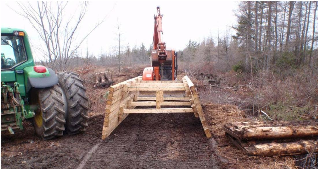
**Figure 29.** Transport de la palissade double (section inférieure), à l'aide de chaînes, jusqu'au site du barrage 6.
