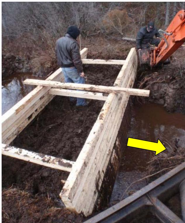
**Figure 34. Installation de la section supérieure du barrage double avec comblement (barrage 6).**
