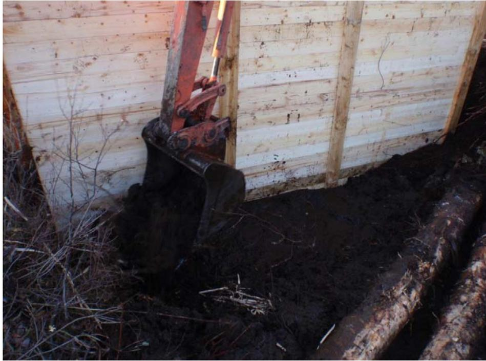
**Figure 19. Enfouissement et stabilisation de la base de la palissade du barrage 4 avec de la tourbe.**
