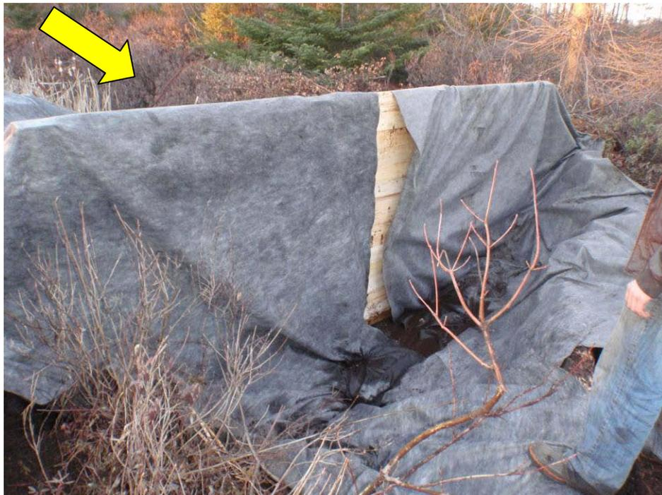
**Figure 20. Formation des poches de géotextile aux extrémités de la palissade du barrage 4.**
