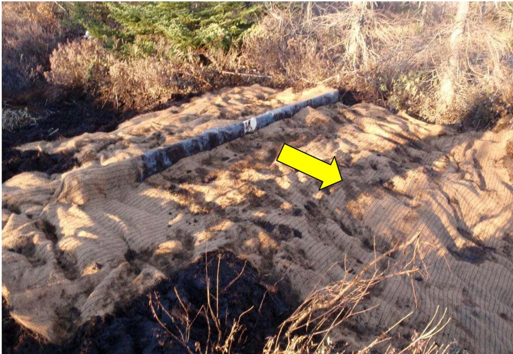
**Figure 23. Pose de filets de coco afin de stabiliser la tourbe contre l'érosion (barrage 4).**
