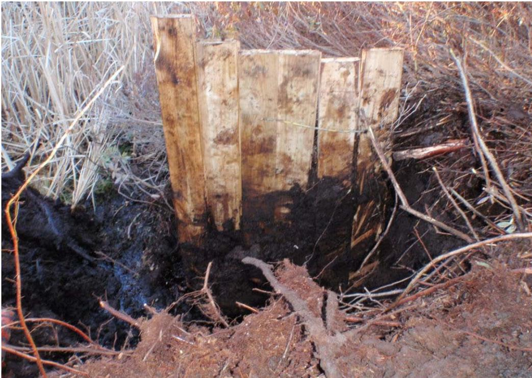
Figure 25. Essaie de la technique d'enfoncement de madriers vertical au barrage 5; constatation des ouvertures entre les madriers.
