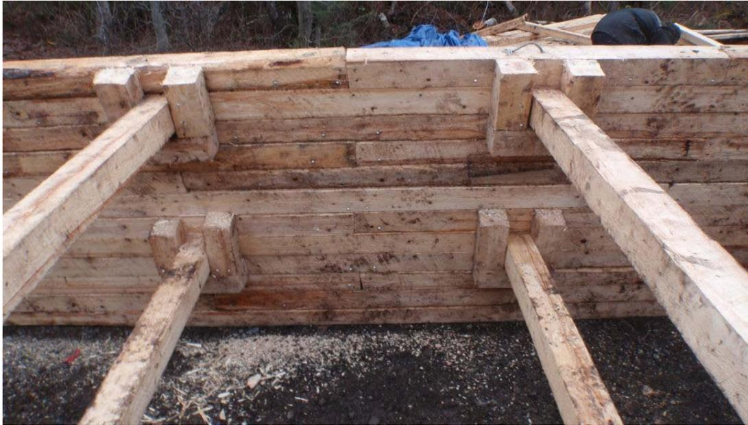
**Figure 28.** Structures en U pour stabiliser les travers de 4x4 lors de leur installation entre les deux palissades (barrage 6).
