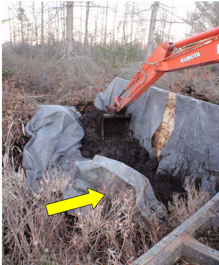
**Figure 21. Enfouissement des poches de géotextile et tassement de la tourbe (barrage 4).**
