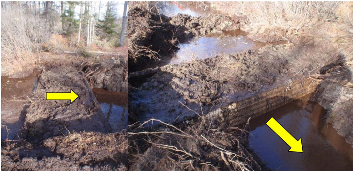
**Figure 33. Section inférieure constituant la base du barrage double avec comblement (barrage 6) prête à recevoir la section supérieure.**
