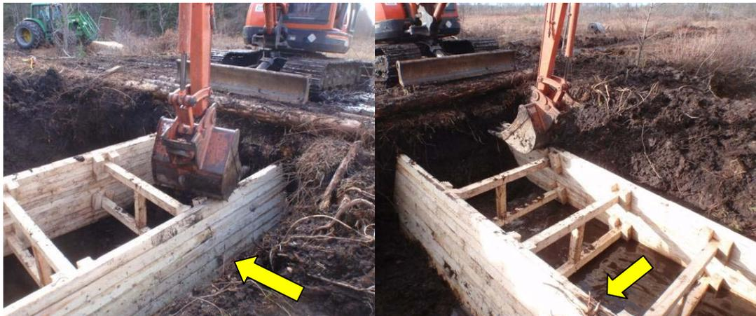
**Figure 31. Installation et mise à niveau de la base de la palissade double à l'aide de la pelle mécanique et enfoncement de cette palissade double dans l'horizon minéral pour la construction du barrage 6.**
