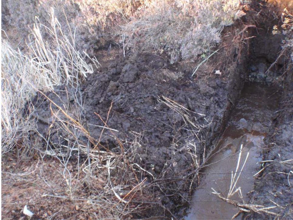
**Figure 15. Excavation de la tranchée et formation de barrages temporaires (barrage 4).**
