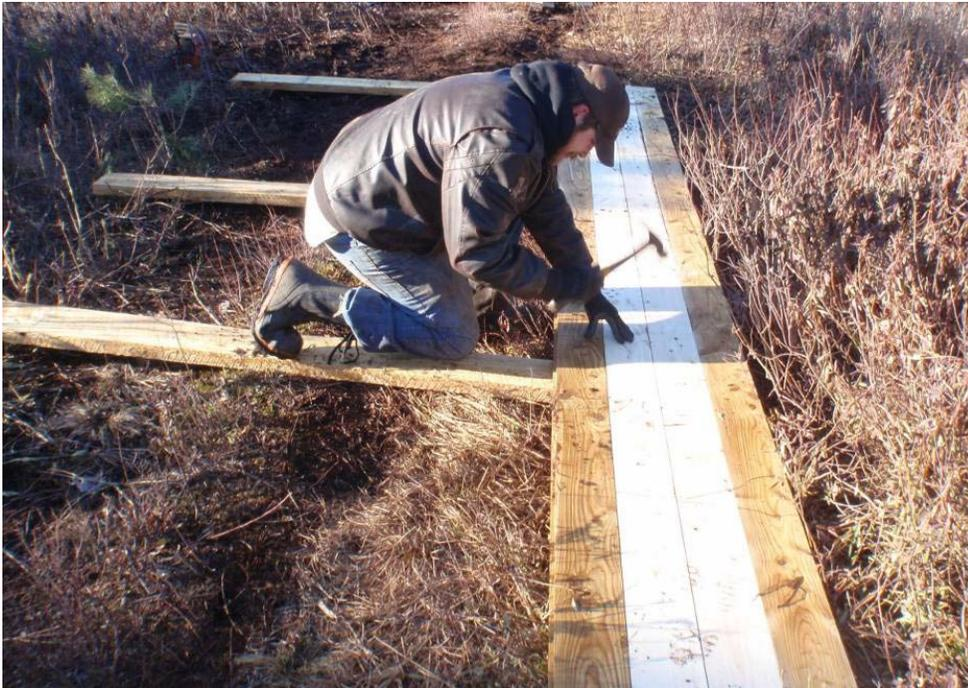
**Figure 16. Construction de la palissade du barrage 4 de madriers de 16 pieds bouvetés (2 pouces x 6 pouces) entre 4 paires de madriers de 8 pieds.**
