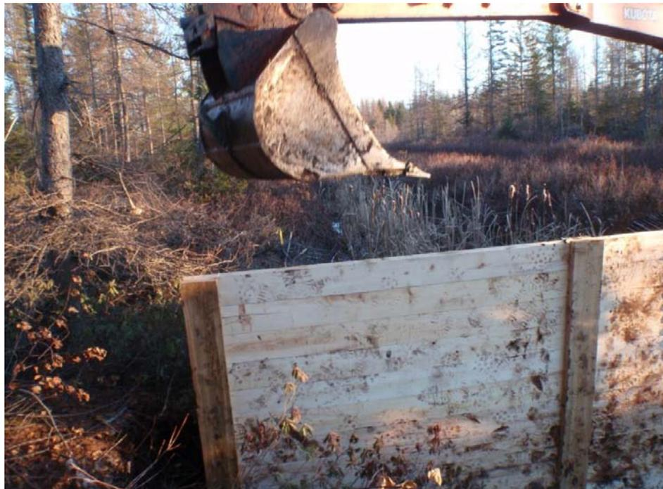
**Figure 18. La pelle mécanique enfonce la palissade du barrage 4 dans la tourbe et l'horizon minéral.**
