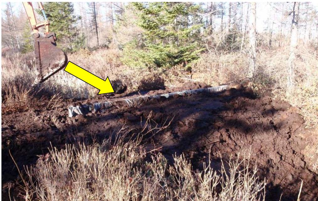
**Figure 22. Formation de pentes douces en amont et en aval de la palissade (barrage 4).**
