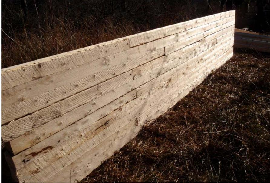
**Figure 5. Barrage 1 : construction d'une palissade horizontale avec madrier de 12 pieds (4 pouces x 4 pouces).**
