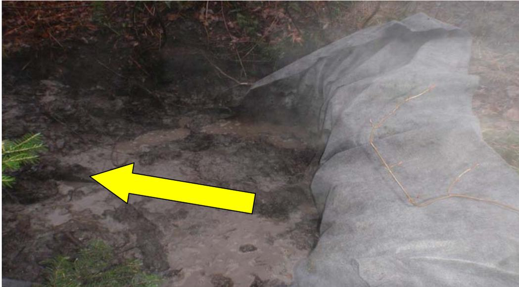
**Figure 13.** Formation d'une poche de géotextile au fond du canal en aval du ponceau (barrage 3).
