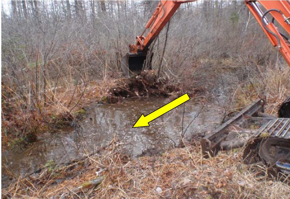
**Figure 3. Formation d'une mare en amont du barrage en préservant la couche superficielle de végétaux qui servira à la végétalisation du barrage de tourbe. Construction du barrage 1 sur le canal Beauharnois.**
