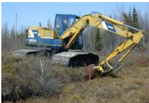
4a. Creusage et nettoyage des canaux.
