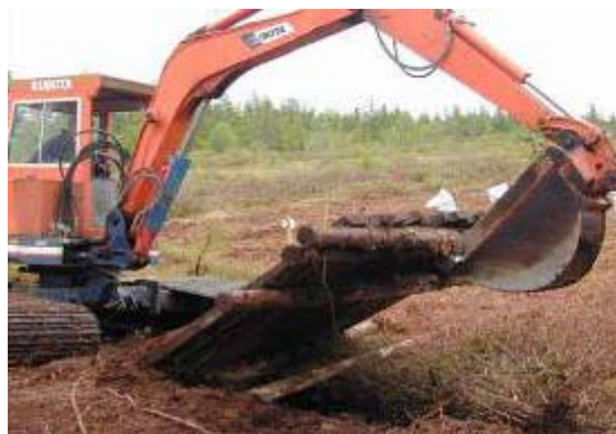
4b. Aménagement de ponceaux.
