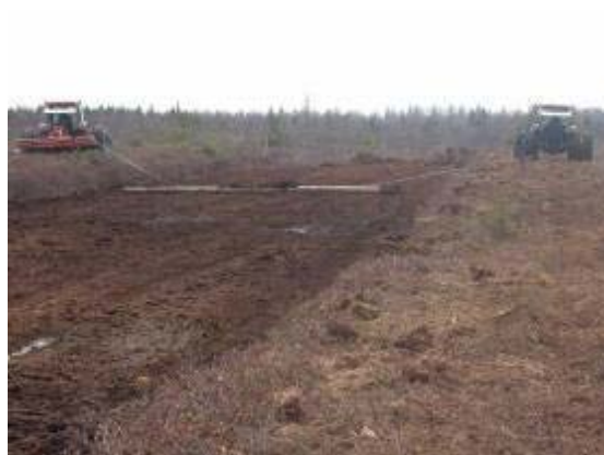
4f. Aplanissement des bassins à l'aide de deux tracteurs et d'un poteau de bois
