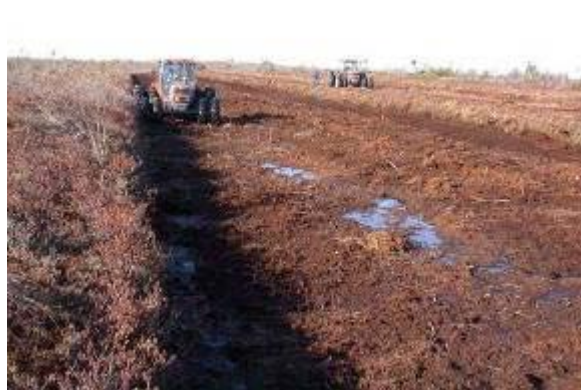
4d. Bassin dont la végétation a été complètement retirée.
