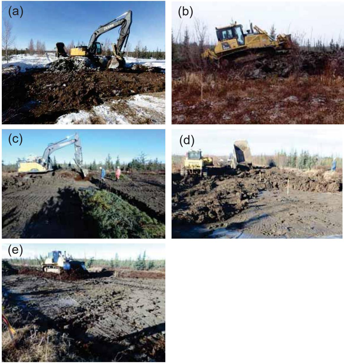
Figure 2. Première étape (étape 1) de la restauration du site d'étude: la préparation du sol avec (a) retrait partiel de la matière minérale de la route; (b) création d'une butte (*upland island*) avec le matériel minéral retiré (c) construction des canaux de circulation d'eau; (d) nivellement du matériel minéral résiduel et (e) ajout du substrat organique au-dessus de la matière minérale résiduelle. Photo a : Marie-Claire LeBlanc. Photos b à e : Christine Isabel.
