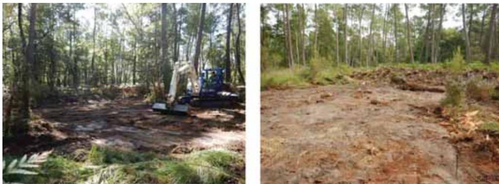
Figure 7. Travaux de restauration des zones humides de la forêt de Chinon (Indre-et-Loire, France), réalisés en septembre 2014.
