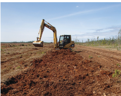
Figure 3. Récolte et ramassage avec une excavatrice avec godet large.
