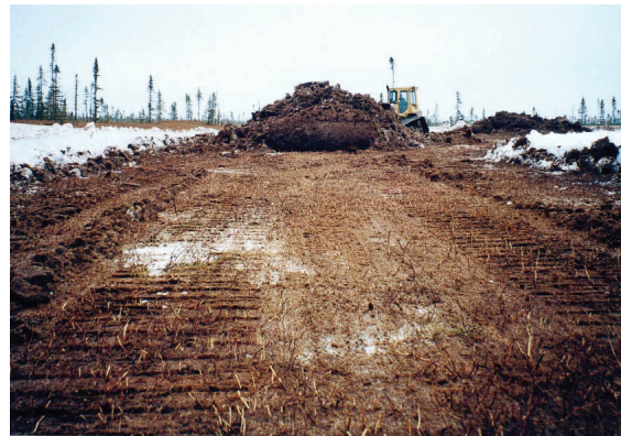
Figure 8. Mise en andain du matériel végétal récolté sur sol gelé.
