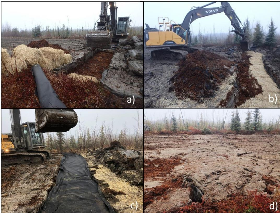
Figure 6 : Construction d'un canal d'écoulement perpendiculaire à la route a) Excavation du canal; b) Remplissage du canal avec des ballots de paille et de la tourbe; c) Ajout d'une couche de géotextile; d) Ajout d'une couche d'argile sur le dessus et aplanissement
