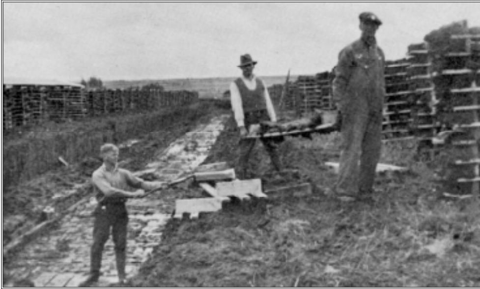
**Figure 2.** Méthode artisanale de la coupe par blocs à la tourbière de l'Isle-Verte, à 18 km à l'est de la tourbière de Cacouna. On distingue nettement la tranchée de minage et les deux terre-pleins adjacents où sont empilés les blocs de tourbe (photographie extraite de Risi *et al.* 1953).
