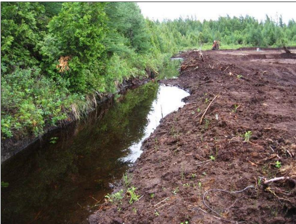
**Figure 21 : Blocage du canal de drainage principal adjacent à la partie est de la tourbière de Bic-Saint-Fabien à l'aide de contreplaqué et d'une membrane géotextile (haut). Les travaux ont permis une remontée considérable du niveau de l'eau (bas).**
