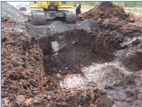
Fig. F. Fosse créée par l'excavation du minéral et de la tourbe. Automne 2012. / Pit created by the excavation of mineral and peat. Fall 2012. Photo : Hydro-Québec
