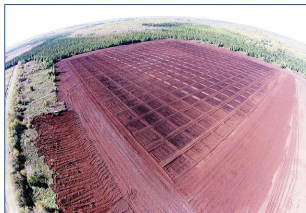
Fig. A. Reprofilage de la surface de tourbe en damier (avec andains) pour un meilleur remouillage de l'ensemble de la tourbière d'Elma North, au Manitoba, en septembre 2015 / *Fig. A. Reprofiled peat fields of the Elma North peatland, in checkboard (with windrows) for a better rewetting effect, in September 2015. Photo : P. Whittington*
