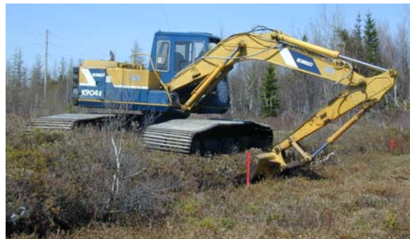
Nettoyage des canaux de drainage
