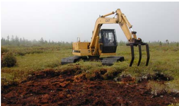
Retrait de la végétation à l'aide d'une excavatrice équipée d'une fourche mécanisée
