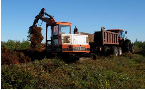
4a. Retrait de la végétation de surface et son transport en dehors de la zone d'étude.
