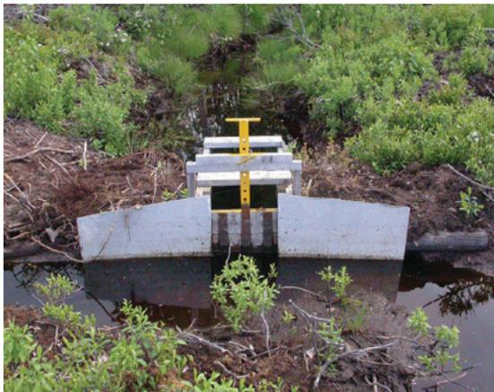
**Figure 15.** Barrage fixe à niveau variable ajustable manuellement.
