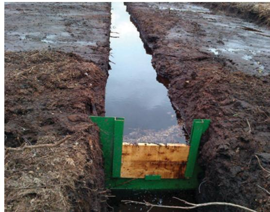
**Figure 16.** Barrage fixe où le niveau maximal du niveau d'eau est ajusté avec l'ajout ou le retrait de planche insérée dans une plaque en acier.
