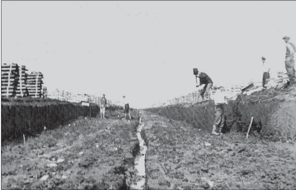
FIGURE 23.3. Tranchée issue de la coupe par blocs et transport de la tourbe hors de la tourbière (photo : Risi *et al.*, 1953).
