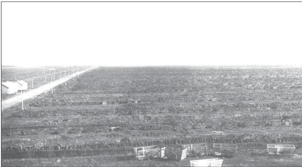
FIGURE 23.4. Vue d'ensemble de la topographie d'une tourbière en exploitation selon la méthode de coupe par blocs; tranchées de minage alternant avec des terre-pleins (photo : Archives provinciales du Nouveau-Brunswick, document P93G61).
