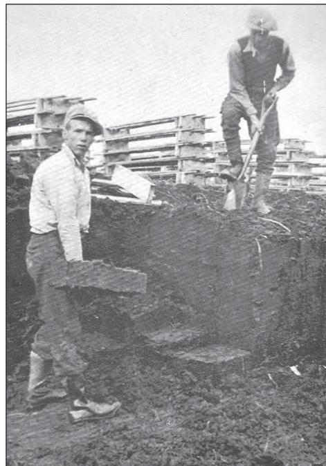
FIGURE 23.2. Jusqu'à la fin des années 1960, l'extraction de la tourbe se faisait par la coupe par blocs. Les blocs de tourbe étaient taillés manuellement à partir d'une tranchée puis déposés sur les terre-pleins pour le séchage (photo : Risi *et al.*, 1953).
